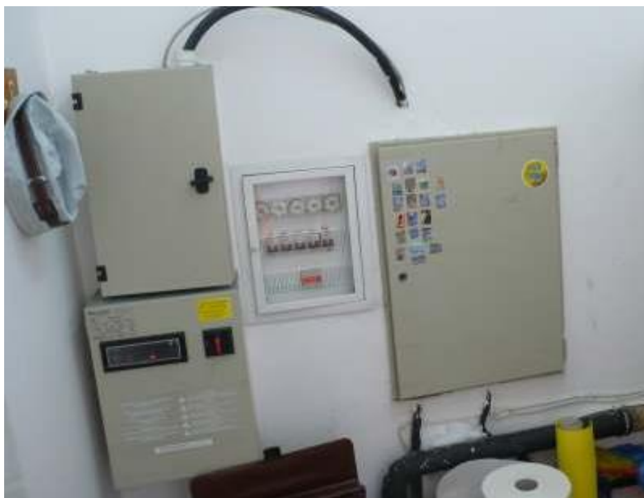
Υφιστάμενος χώρος ηλεκτρικών πινάκων και βανών κλιματισμού ("μηχανοστάσιο").
